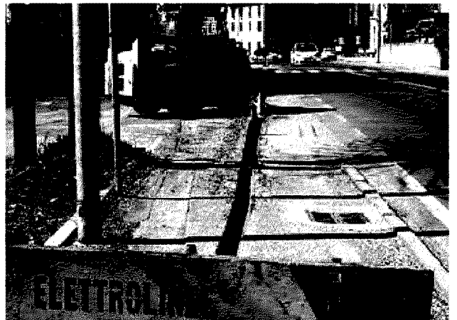
Valsabbia: la posa della fibra ottica della banda ultralarga
